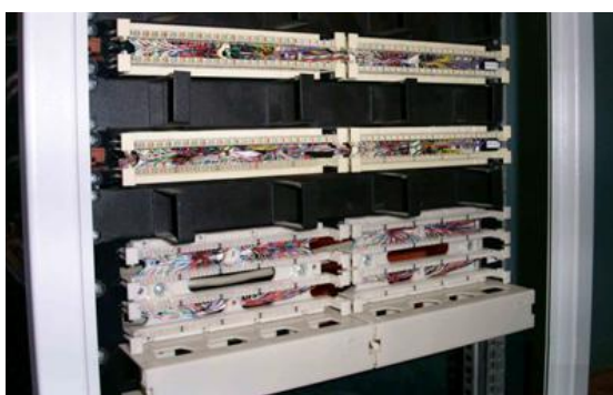
Рис.2.7. Кроссовые панели с соединительными блоками 110 типа.
