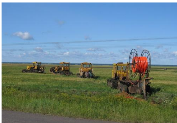
Рис. 5.2. Прокладка труб непосредственно в грунт
