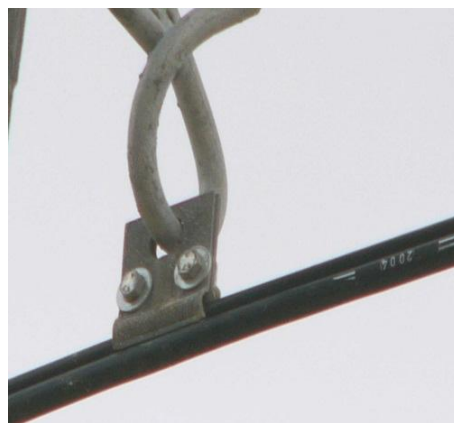
Рис. 5.11. Подвеска ВОК типа «восьмерки»
