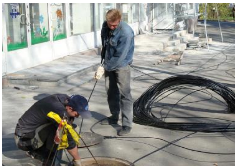
Рис. 5.6. Затягивание ВСК в кабельную канализацию
