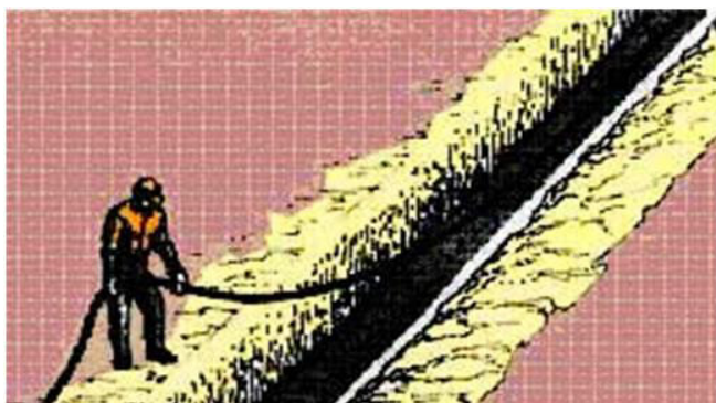
Рис. 4.4. Ручная прокладка ОК в траншею
