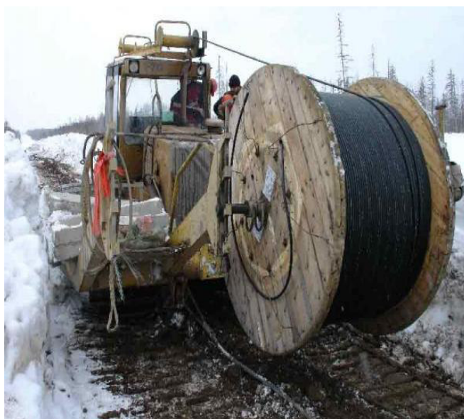
Рис. 4.3. Прокладка ВОК в отрытую траншею
