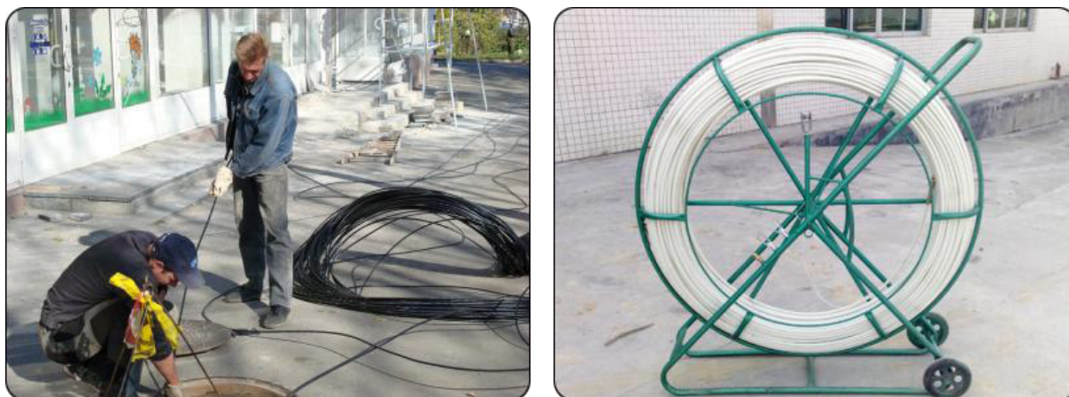
Рис. 4.5. Прокладка ВОК в кабельную канализацию
