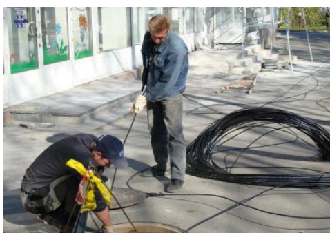
Рис. 5.6. Затягивание ВОК в кабельную канализацию
