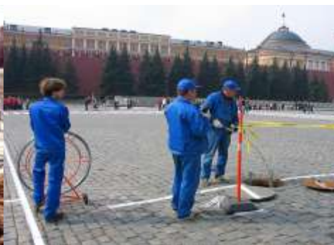
Рис.9.6. Кабельная канализация.
