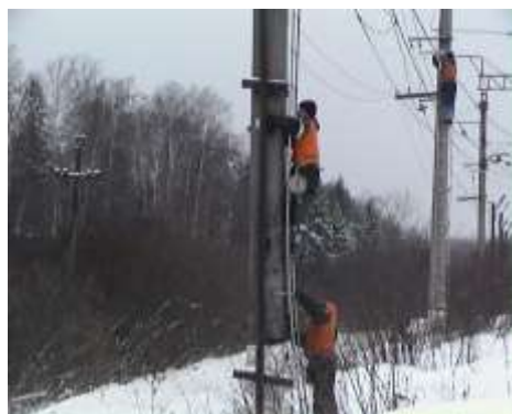
Рис.9.14. Монтаж и элементы крепления ВОК.
