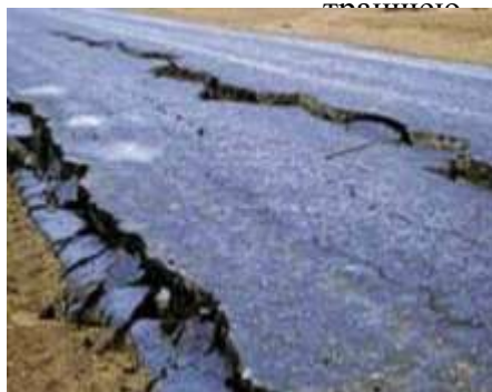
Рис.5.8. Перемещение грунта в результате землетрясения.
