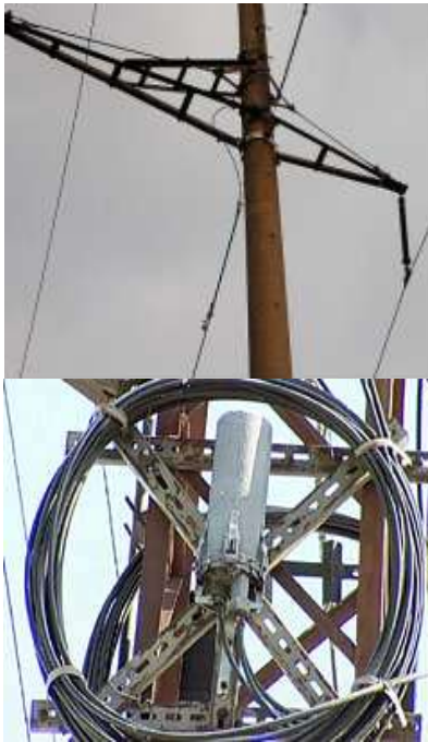
Рис.5.12. Крепление самонесущего ВОК к опоре
