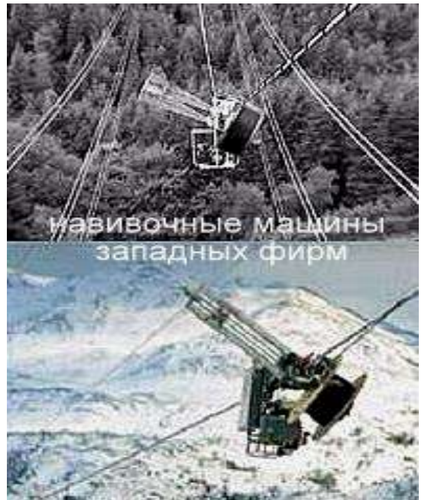
Рис.6.11. Строительство ВОЛС на основе самонесущих ВСК.
