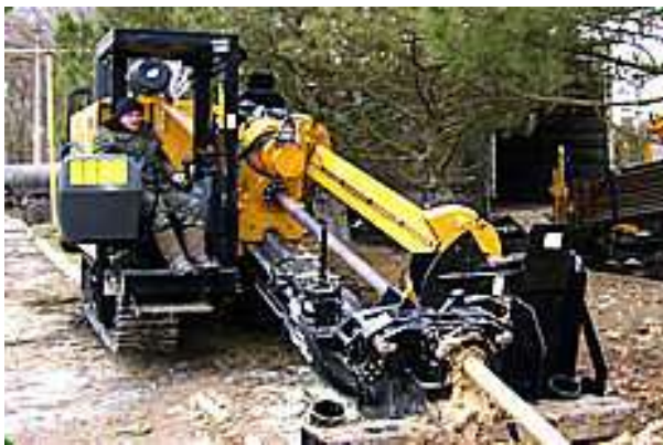
Рис 6.7. Организация переходов методом горизонтально-направленного бурения.
