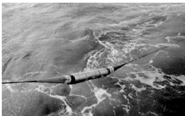
Рис. 30. Установка подводного оптического усилителя в открытом море [14].
