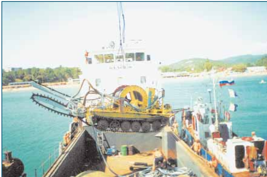
Рис. 1. Бухта Джубга. Кабельное судно-база «Акватик-6» и водолазный бот. Судовой подъемный кран поднимает «подводный танк» из грузового трюма. На «подводном танке» видна баровая установка и барабан с полиэтиленовой трубой.
