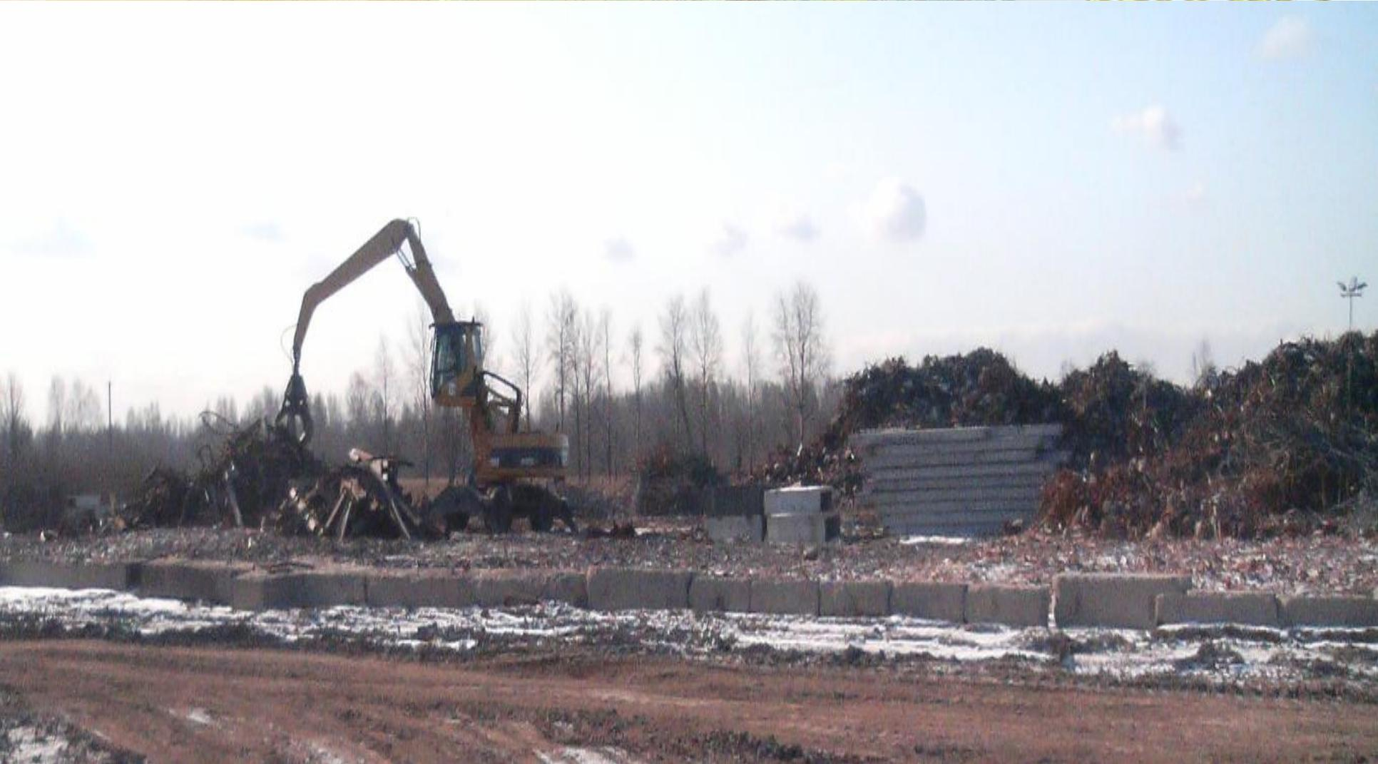
**Разборка строительных отходов с извлечением металлических отходов**
