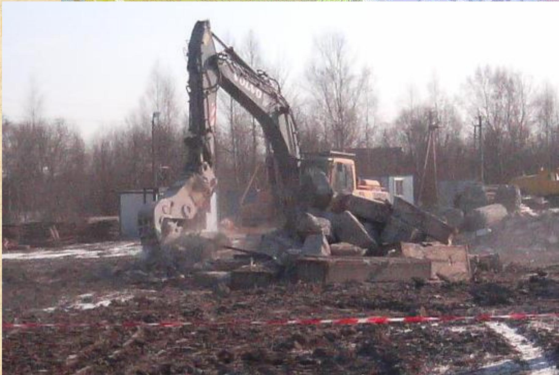
**Предварительное дробление крупных кусков железобетона**
