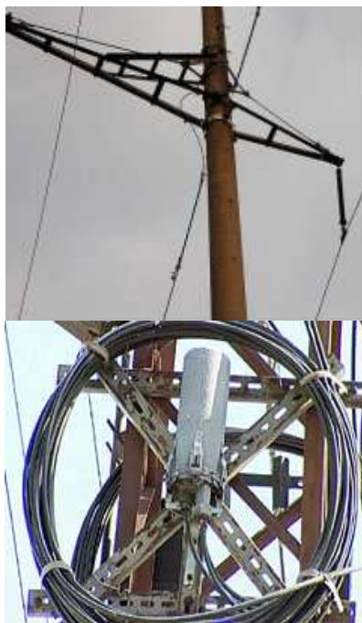
Рис.5.12. Крепление самонесущего ВОК к опоре
