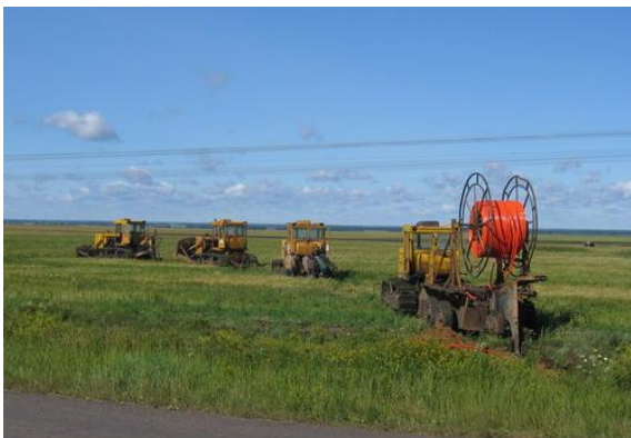
Рис. 5.2. Прокладка труб непосредственно в грунт
