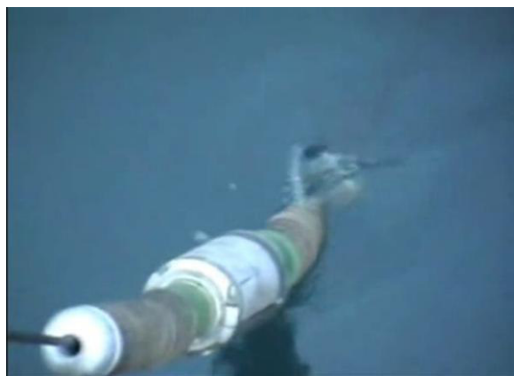
Рис. 8.2. Строим подводную ВОЛС
