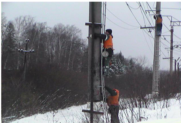
Рис. 5.7. Монтаж самонесущего ВОК
