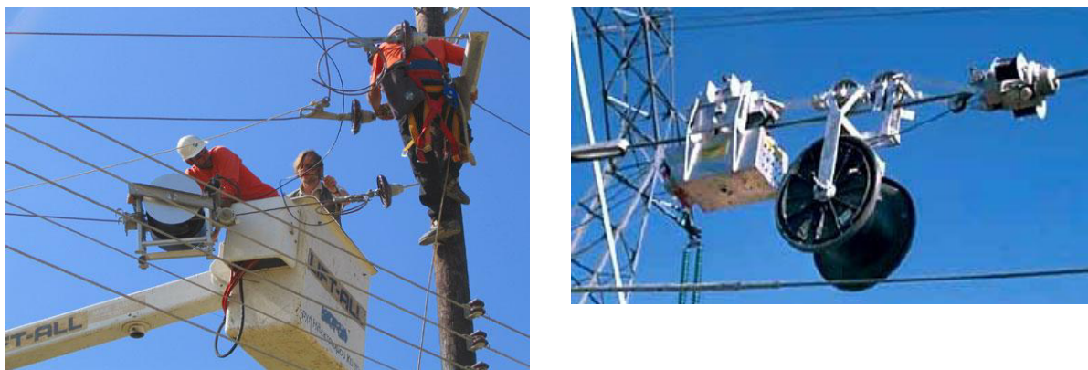
Рис. 5.15. Подмотка волоконно-оптического кабеля к тросу грозозащиты
