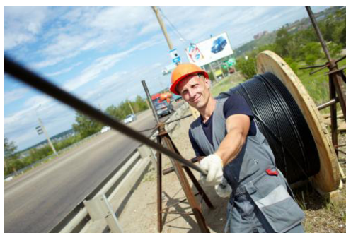
Рис. 8.1. Строительство ВОЛС Киров – Пермь
