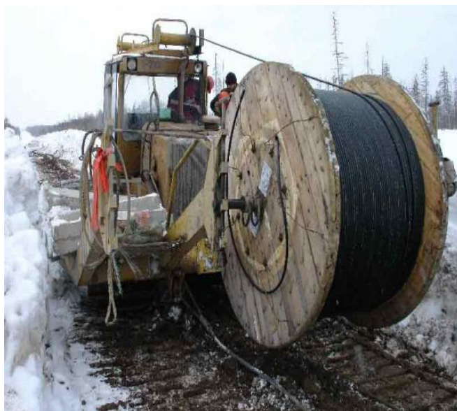
Рис. 4.3. Прокладка ВОК в отрытую траншею
