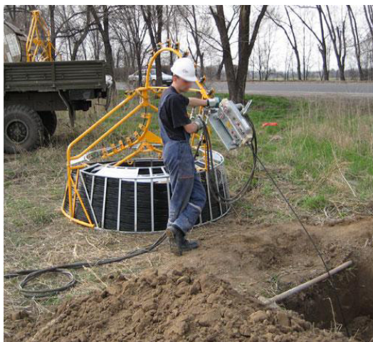
Рис. 4.6. Устройство укладки ВОК типа «Figaro»
