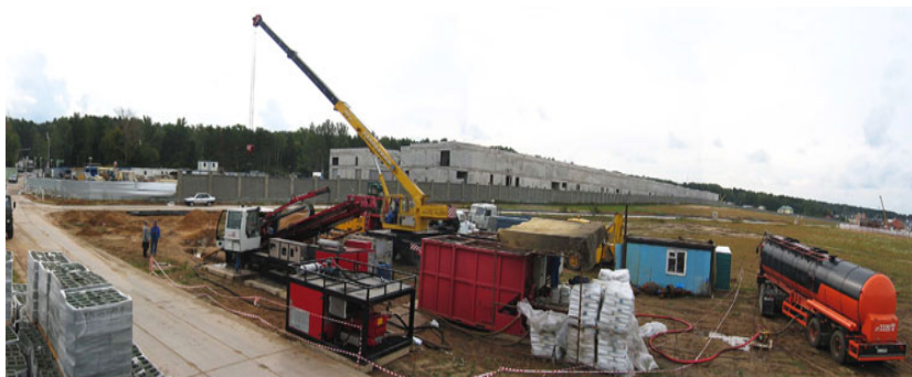
Рис. 3.9. Площадка, где размещается оборудование для горизонтально-направленного бурения
