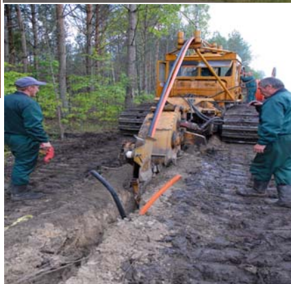
Рис. 3.5. Прокладка труб (кабеля) непосредственно в грунт
