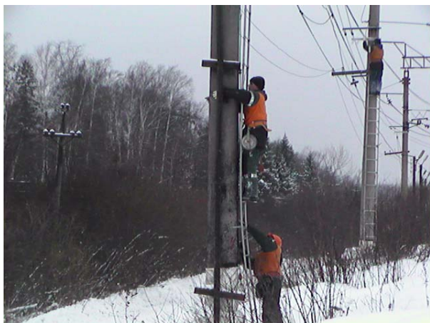
Рис. 3.20. Монтаж самонесущего ВОК
