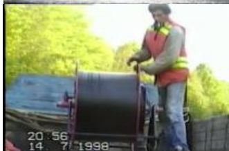
Процесс развертывания первого элемента ВОКВ
