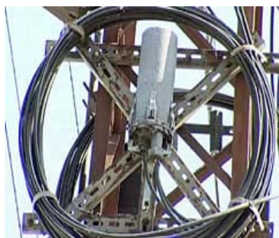
Рис. 5.12. Крепление самонесущего ВОК к опоре:
