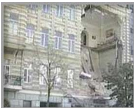
Рис. 5.15. Обрушение и просаживание фундаментов зданий
