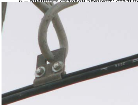
Рис. 3.15. Подвеска ВОК типа «восьмерка»
