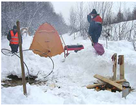
Рис. 5.9. Прокладка и монтаж кабеля в мороз
