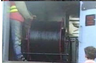
Процесс развертывания элемента ВОКВ из ремонтной машины
