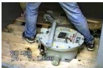
Подготовка к подключению оптической муфты
