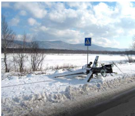
Рис. 5.14. Повреждения опор ЛЭП и подвешенной на них ВОЛС
