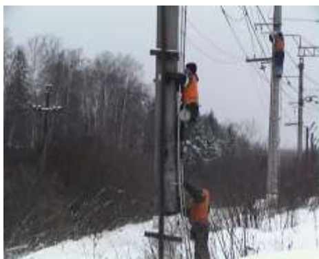
Рис.9.14. Монтаж и элементы крепления ВОК.
