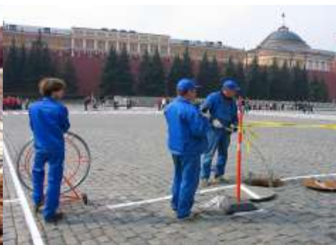
Рис.9.6. Кабельная канализация.
